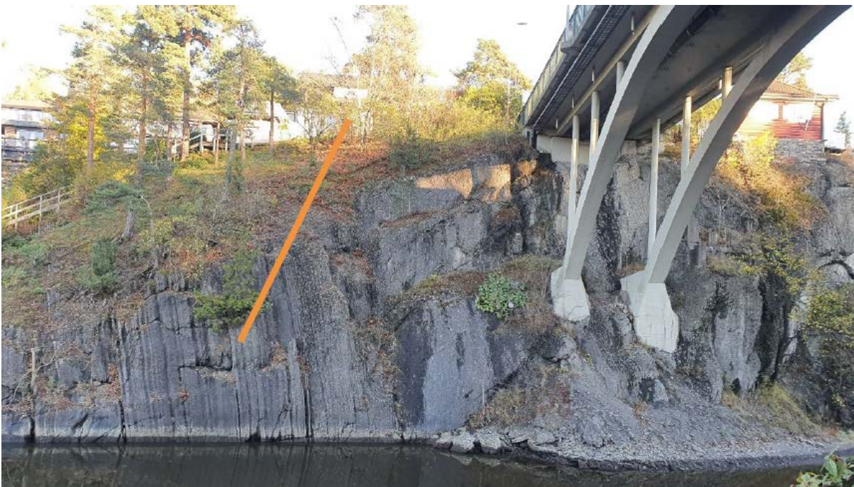
Figur 13: Bildet viser østre del av sundet med steile kalkbergvegger og grunnlendt kalkskog og små arealer med åpen grunnlendt kalkmark. Oransje strek viser grense for hvor de viktigste arealene er i øvre del av skrenten. Det er arealene nord for denne (venstre) som har den mest intakte naturen. Sør for streken er det mer påvirket. (kilde: Biofokus)
